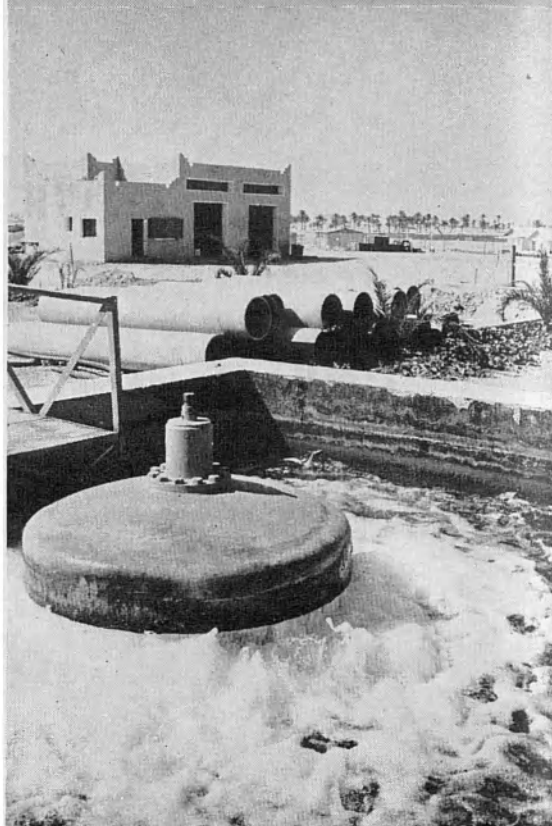
Pozo artesiano de Uargla, en el Sahara. Aquí el agua se oculta bajo el lecho del desierto. El agua artesiana se ve alcanzada a profundidades variables en las perforaciones: 75 metros en El Golea, 1.000 ms. en Uargla, 1.500 ms. en Tugurt. La reserva de agua de la inmensa cuenca artesiana del Sahara se calcula en 12 billones de metros cúbicos.
