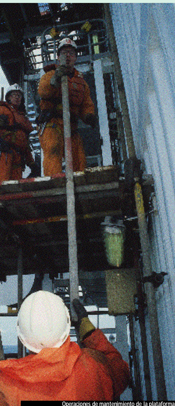
Operaciones de mantenimiento de la plataforma.
