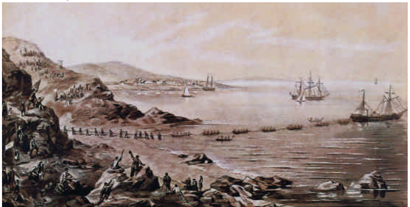
Instalación de un cable telegráfico submarino desde la isla de Valencia, en el oeste de Irlanda. Grabado de 1857.
