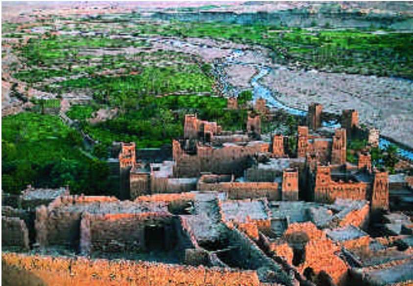
Las técnicas clásicas son poco eficaces para restaurar de manera duradera las construcciones de adobe.
