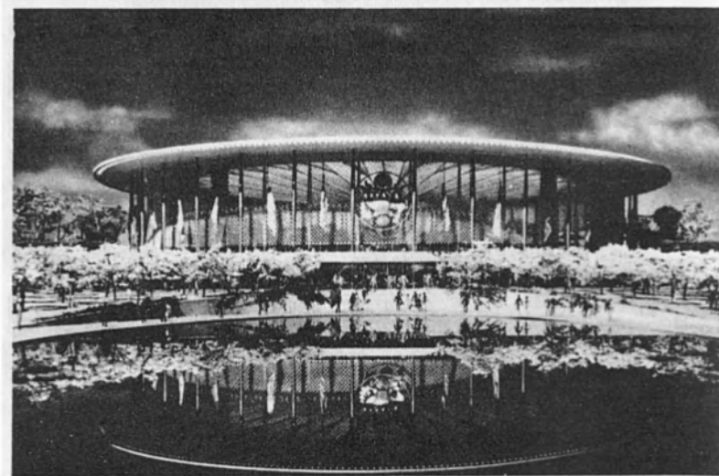
EL PABELLON DE LOS ESTADOS UNIDOS será el más vasto edificio circular del mundo. Estará construido en material plástico y tendrá un techo suspendido sobre columnas de acero.
