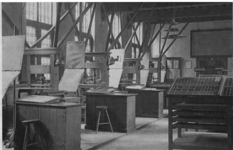
Transformados hoy en el Museo Plantin y Moretus de Amberes, el taller de imprenta y la residencia de Cristóbal Plantin se conservan en su forma original.
