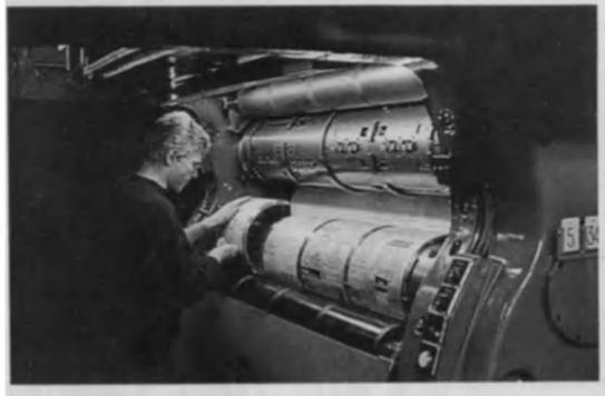
Preparando la impresión de un periódico en una rotativa.
