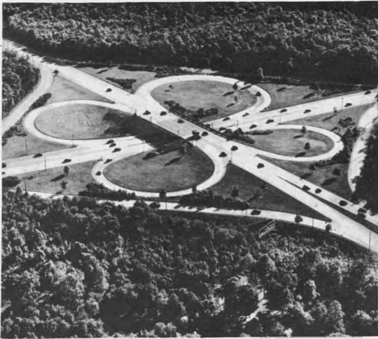
UNA FLOR DE CUATRO HOJAS formada por el cruce de autopistas cerca de Nueva York. Este cruce de amplias curvas graduales es la aplicación de la fórmula clásica de intersección de carreteras que permite a los automóviles cruzar o cambiar de dirección sin cortar las líneas del tráfico.
