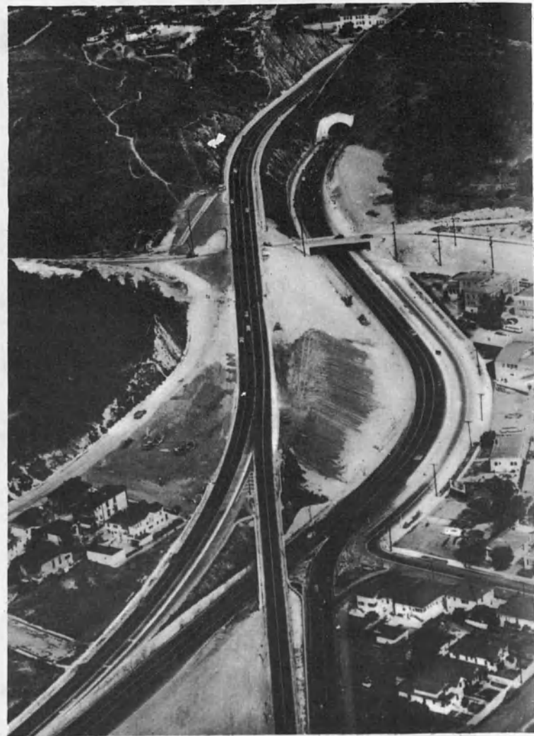
ESLABONES DEL TRÁFICO. Cerca de Detroit, en Michigan, estas dos autopistas —una con doble línea de tránsito y otra a lo largo del Lago Michigan— están enlazadas por rampas y pasos subterráneos. Este sistema facilita el tráfico a gran velocidad y elimina las intersecciones peligrosas:
