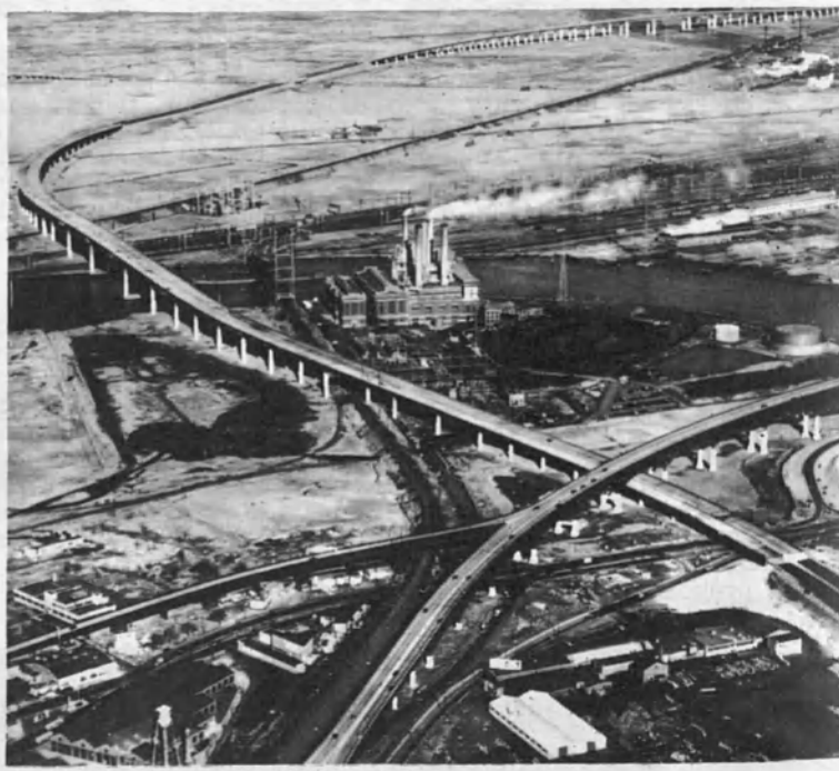
• LA “NUEVA JERSEY TURNPIKE” es una autopista moderna que atraviesa el río Passaic (centro) y el río Hackensack (arriba, a la derecha). En el primer plano, se ve a horcajadas sobre ella la autopista Pulaski que conduce el tráfico hacia el lado occidental de la ciudad de Nueva York.
