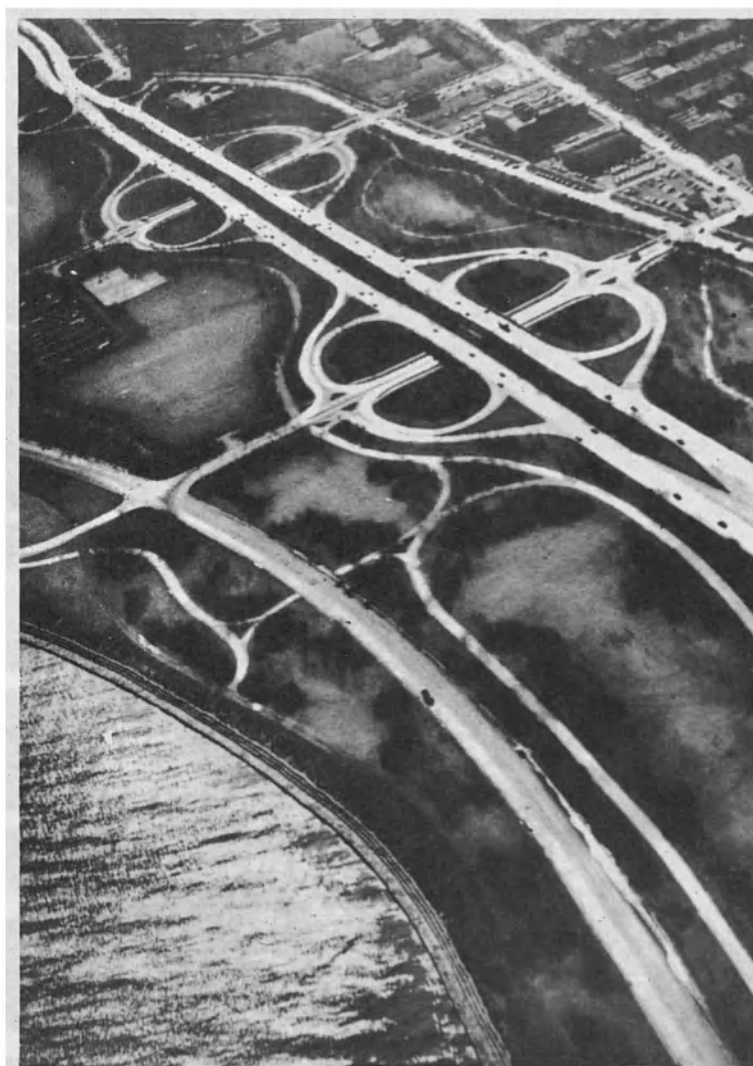
EL PROBLEMA DE LA CIRCULACIÓN en California —tres millones de automoviles en 1940, seis millones en 1955— ha conducido a la construcción acelerada de 1.600 kilómetros de autopistas. Arriba se puede ver una sección de la autopista que enlaza Pasadena con Los Angeles, Calif.
