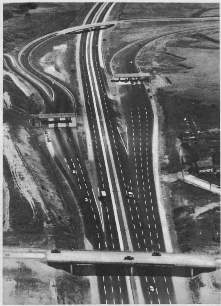
SE PAGA AL PASAR. Puesto de portazgo (parte superior de la foto) en la autopista de Nueva Jersey (centro). El tráfico principal se efectúa por la vía central. Las vías laterales (izquierda y derecha) comunican con el Túnel de Lincoln que pasa bajo el río Hudson y conduce a Nueva York.
