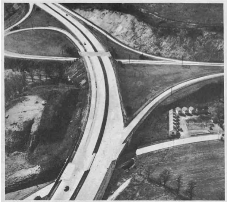
LA AUTOPISTA DE PENNSILVANIA , terminada en 1954, fué una de las primeras de los Estados Unidos. Tiene una longitud de más de 550 kilómetros, desde el río Delaware, en el este, hasta la frontera del Estado de Ohio, en el oeste, y enlaza Filadelfia con la de la ciudad de Pittsburgh.
