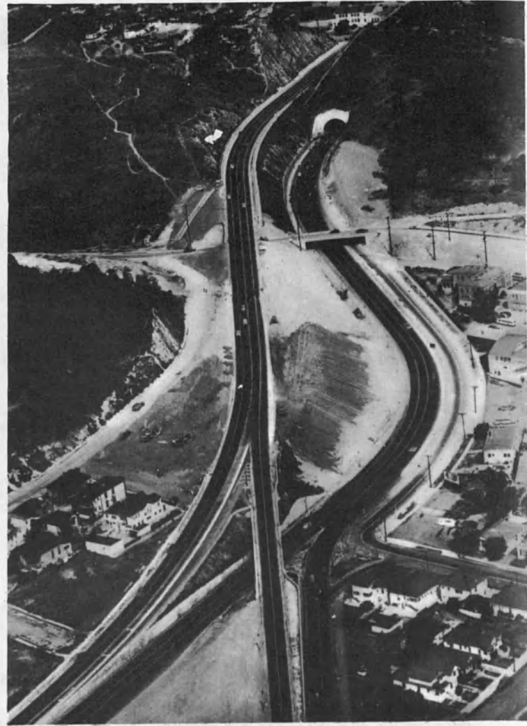
ESLABONES DEL TRÁFICO. Cerca de Detroit, en Michigan, estas dos autopistas —una con doble línea de tránsito y otra a lo largo del Lago Michigan— están enlazadas por rampas y pasos subterráneos. Este sistema facilita el tráfico a gran velocidad y elimina las intersecciones peligrosas:
