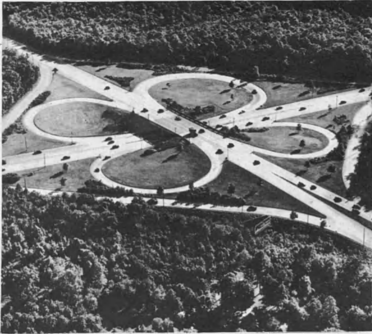
UNA FLOR DE CUATRO HOJAS formada por el cruce de autopistas cerca de Nueva York. Este cruce de amplias curvas graduales es la aplicación de la fórmula clásica de intersección de carreteras que permite a los automóviles cruzar o cambiar de dirección sin cortar las líneas del tráfico.
