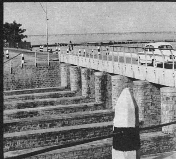
EL PUENTE MAS LARGO. El puente que se ve en el horizonte en nuestra foto ha sido construido en la India, aproximadamente a unos 600 kms. de Calcuta. Este puente, que cruza el río Sone, es, con sus 3.300 ms., el más largo de toda el Asia. En el Pakistán oriental se construirán otros siete grandes puentes.
