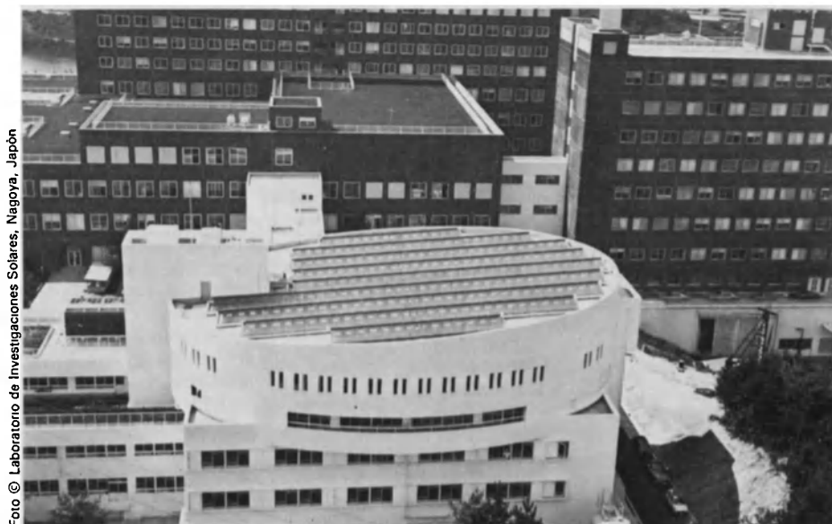
El hospital de la Facultad de Medicina de la Universidad Kinki de Osaka, Japón, obtiene el agua caliente que necesita mediante 1.856 tubos colectores de rayos solares instalados en el tejado.
