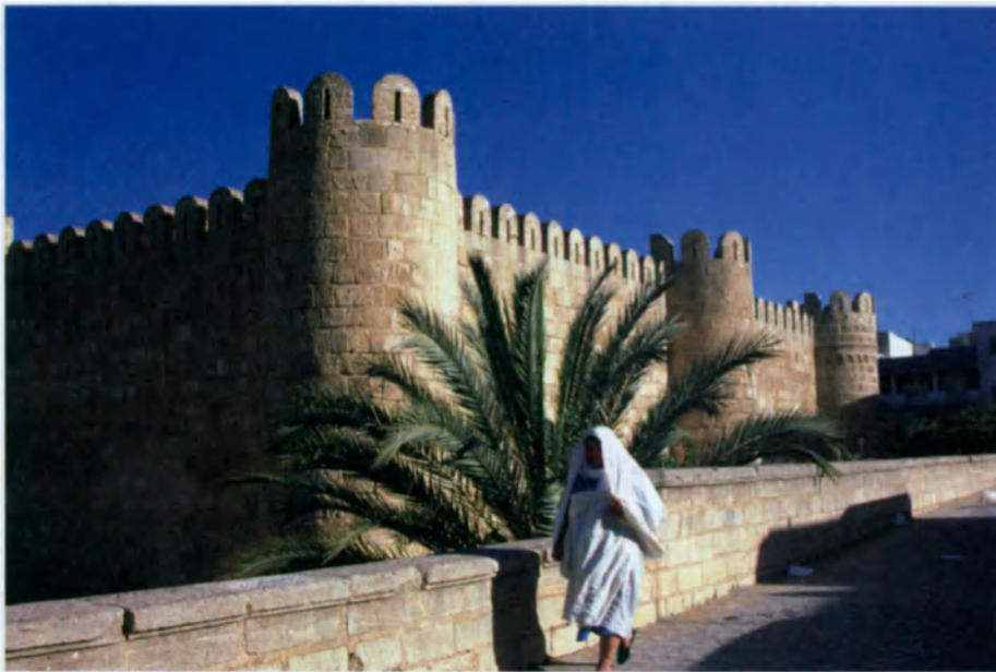
Arriba, el Ribat, monasterio fortificado de fines del siglo VIII, defendido por una muralla cuadrada de cerca de 30 m de lado con torres semicilíndricas en los ángulos y los costados.
