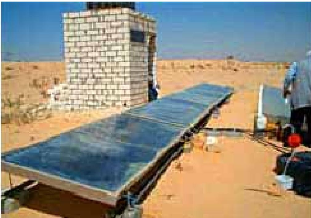
Sistema de desalinización a base de energía solar.
