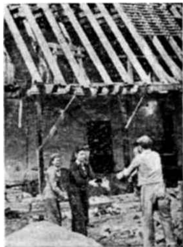
Reparación de escuelas
