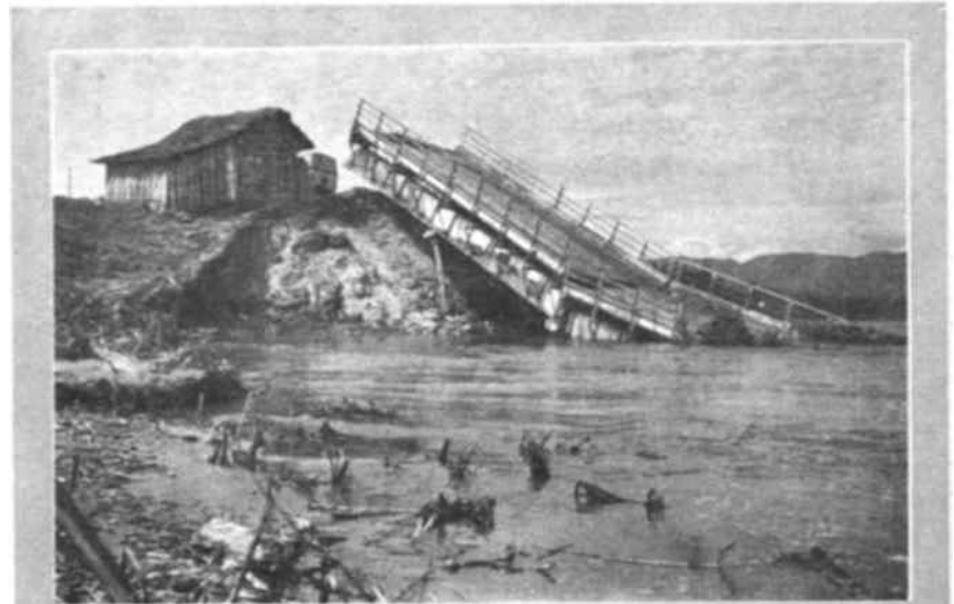
El puente de Ranganadi cerca de la aldea de Lakhimpur del Norte fué destruido por la riada y bloqueado por enormes cantos rodados en las colinas hasta las cuales encontró libre el camino. Este puente, de cerca de cuatrocientos metros de longitud, era de importancia vital y el más largo en la región de Assam.
