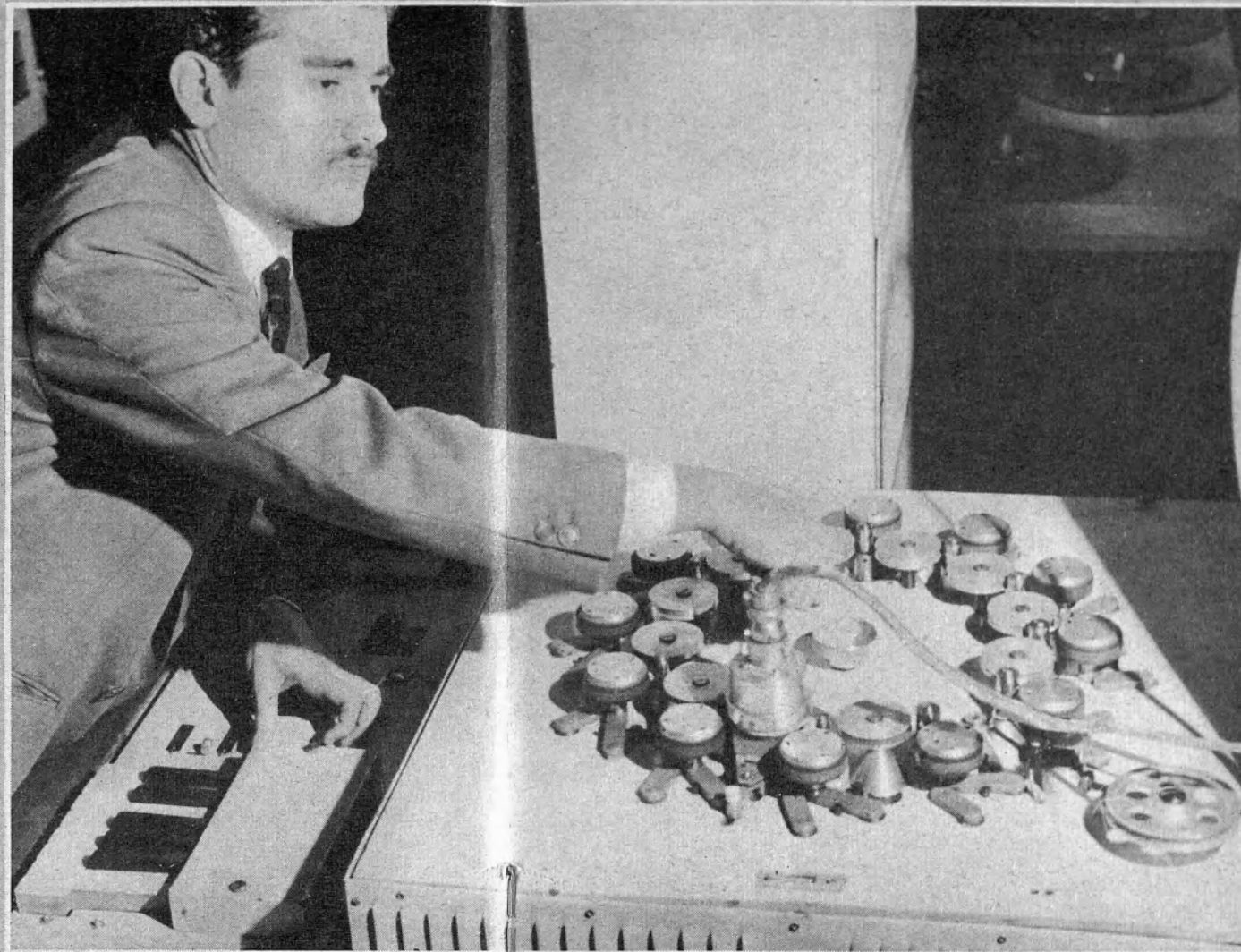
EL EJECUTANTE: El clavicordio del Fonogeno Cromático permite leer los sonidos a velocidades diferentes escalonadas de acuerdo con la gama. Así se realiza la transposición cromática de las melodías y del compás. Esa clase de clavicordio tiene que ser tocado por un virtuoso, de preferencia el mismo compositor.
