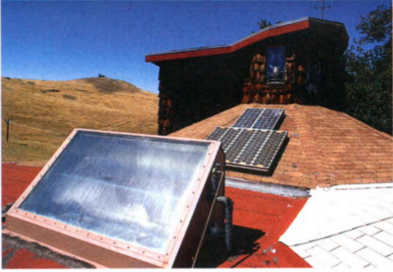
Paneles solares en el techo de una casa (Estados Unidos).
