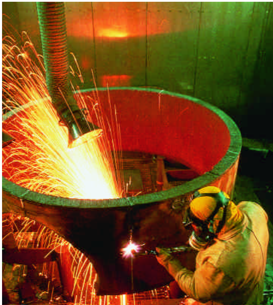
Una de las etapas del desmantelamiento consiste en desmontar las estructuras auxiliares.
