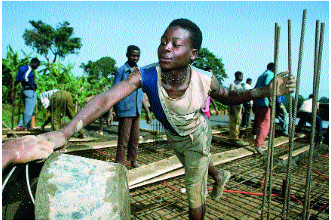
Construcción de una escuela en Bafoussan, Camerún.
