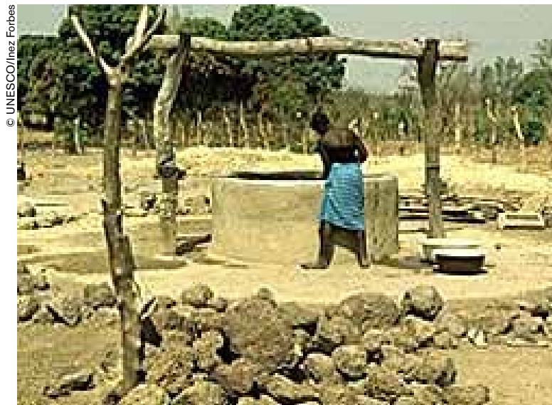
Pozo en Mali.
