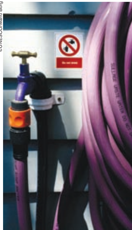
Tuberías para aguas residuales, Melbourne, Victoria, Australia.
