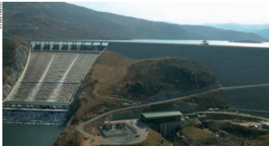
Una presa en Swazilandia.
