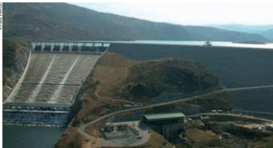
Una presa en Swazilandia.
