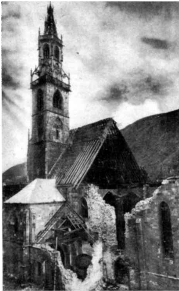
En Bolzano, donde el techo de la catedral sufrió serios perjuicios, los arquitectos encargados de su reparación, se abocaron con el problema creado por la escasez de ciertos materiales de construcción, particularmente madera. Como la presente foto muestra (arriba, a la derecha), superaron la dificultad reemplazando las vigas de madera por obra de cemento.
