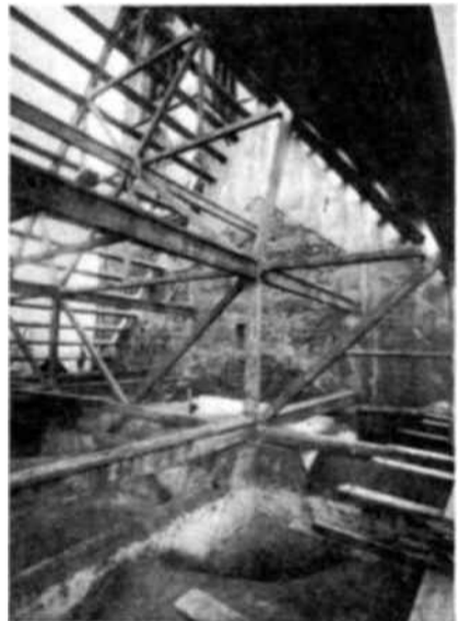
En Bolzano, donde el techo de la catedral sufrió serios perjuicios, los arquitectos encargados de su reparación, se abocaron con el problema creado por la escasez de ciertos materiales de construcción, particularmente madera. Como la presente foto muestra (arriba, a la derecha), superaron la dificultad reemplazando las vigas de madera por obra de cemento.
