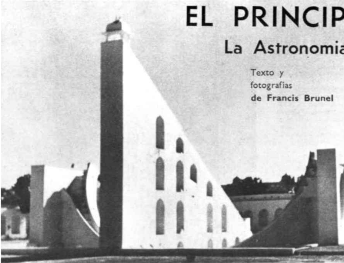
EL SAMRAT YANTRA. — Con su triángulo gigante de 20 metros de altura, el observatorio se halla emplazado sobre el plano meridiano, es decir, orientado de Norte a Sur y apuntando hacia el polo norte.
