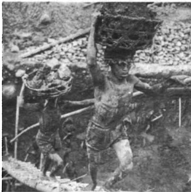
Los campesinos de Java están abriendo un canal de noventa kilómetros de extensión sin otra cosa que sus propios músculos y una serie de zapapicos, y palas. Al tropezar con roca, no emplean dinamita, porque la mano de obra es más barata allí que los explosivos.
