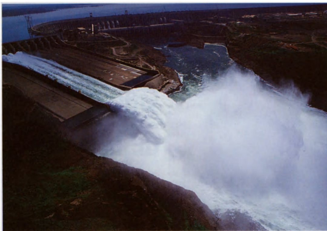
La presa de Itaipú, construida en el río Paraná por Paraguay y Brasil.
