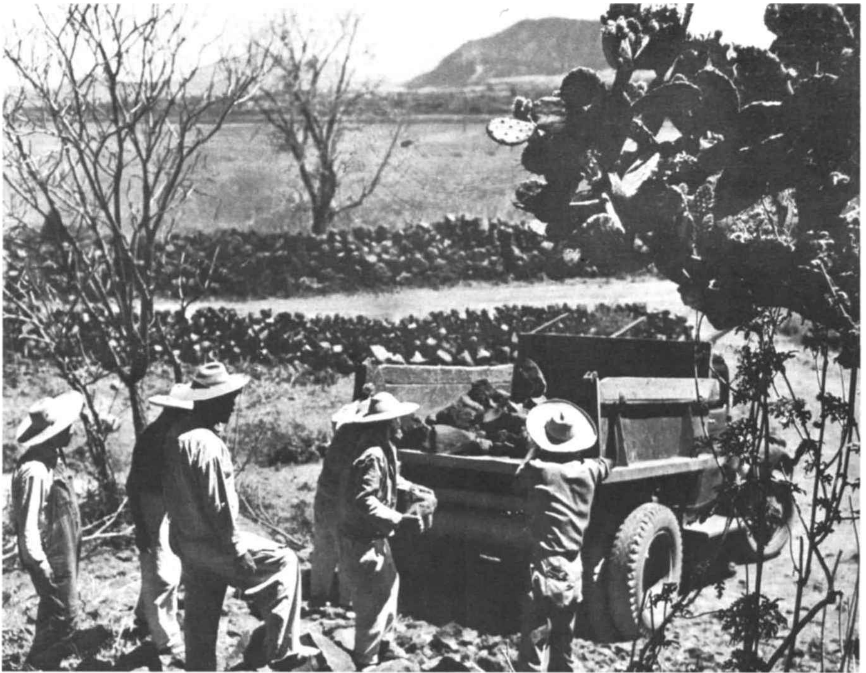
Bajo el sol candente, a orillas del Lago Pátzcuaro, los aldeanos cargan las piedras destinadas a construir el camino que ellos mismos han decidido hacer.
