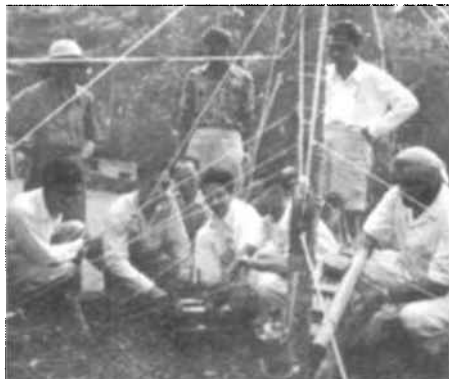
Los especialistas montan aquí el sistema teleférico para el transporte de los troncos.
