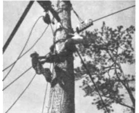
Después fijan los cables para el transporte de los árboles, por este ingenioso sistema.
