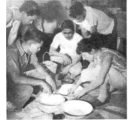
La Señorita Mary Risley, ceramista de la ONU muestra a los cursillistas como se construye un horno. Expone un método de producción rápida y sencilla: un molde en yeso y una plantilla dan excelentes resultados, si se mezclan del modo debido diferentes calidades de arcilla.
