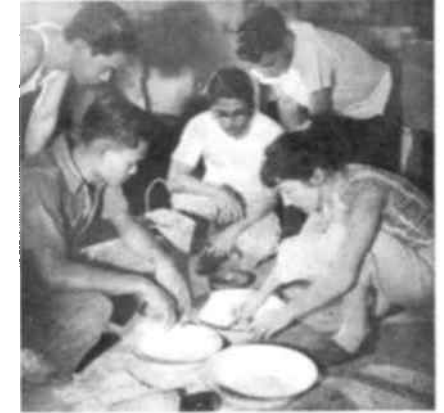
La Señorita Mary Risley, ceramista la ONU muestra a los cursillistas como se construye un horno. Expone un método de producción rápida y sencilla: un molde en yeso y una plantilla dan excelentes resultados, si se mezclan del modo debido diferentes calidades de arcilla.
