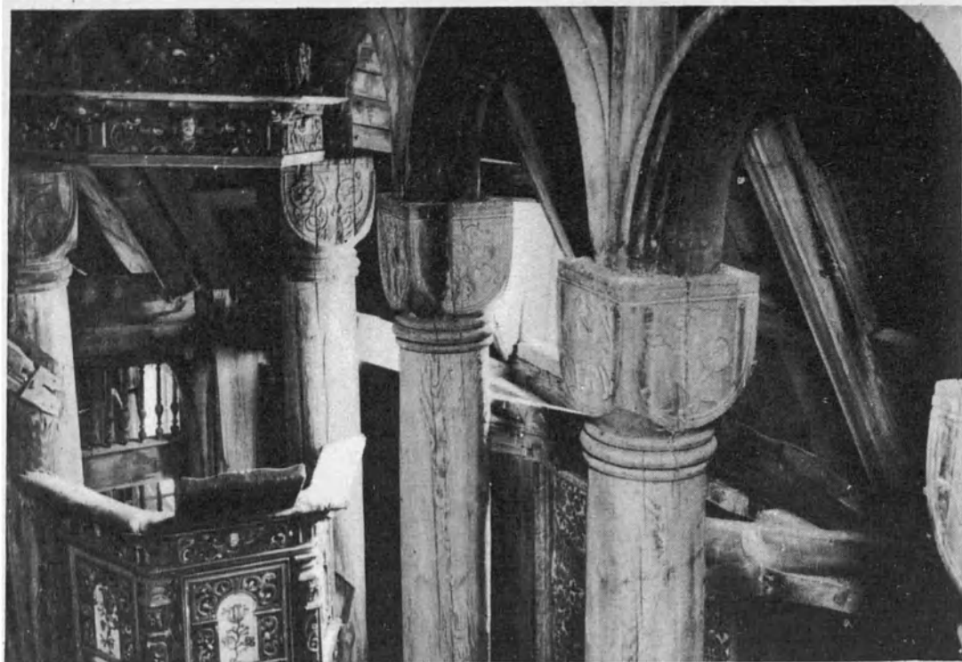
DETALLE DE LA ARCADA DE LA IGLESIA DE URNES
