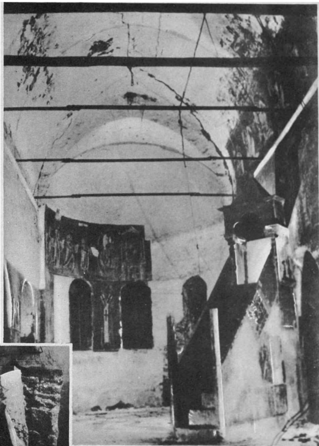
El coro de Santa Sofía de Ochrida, en el estado en que se hallaba al comenzar los trabajos de restauración. La mayor parte de los frescos permanecían ocultos aún bajo el yeso. Para limpiar la bóveda se construyó un andamio, y se descubrieron varios frescos (página 39). El detalle aquí presentado muestra cómo se puede desprender la pintura del yeso aplicando sobre su superficie un lienzo impregnado de cola.
