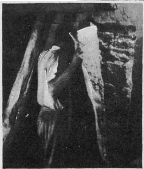
El coro de Santa Sofía de Ochrida, en el estado en que se hallaba al comenzar los trabajos de restauración. La mayor parte de los frescos permanecían ocultos aún bajo el yeso. Para limpiar la bóveda se construyó un andamio, y se descubrieron varios frescos (página 39). El detalle aquí presentado muestra cómo se puede desprender la pintura del yeso aplicando sobre su superficie un lienzo impregnado de cola.
