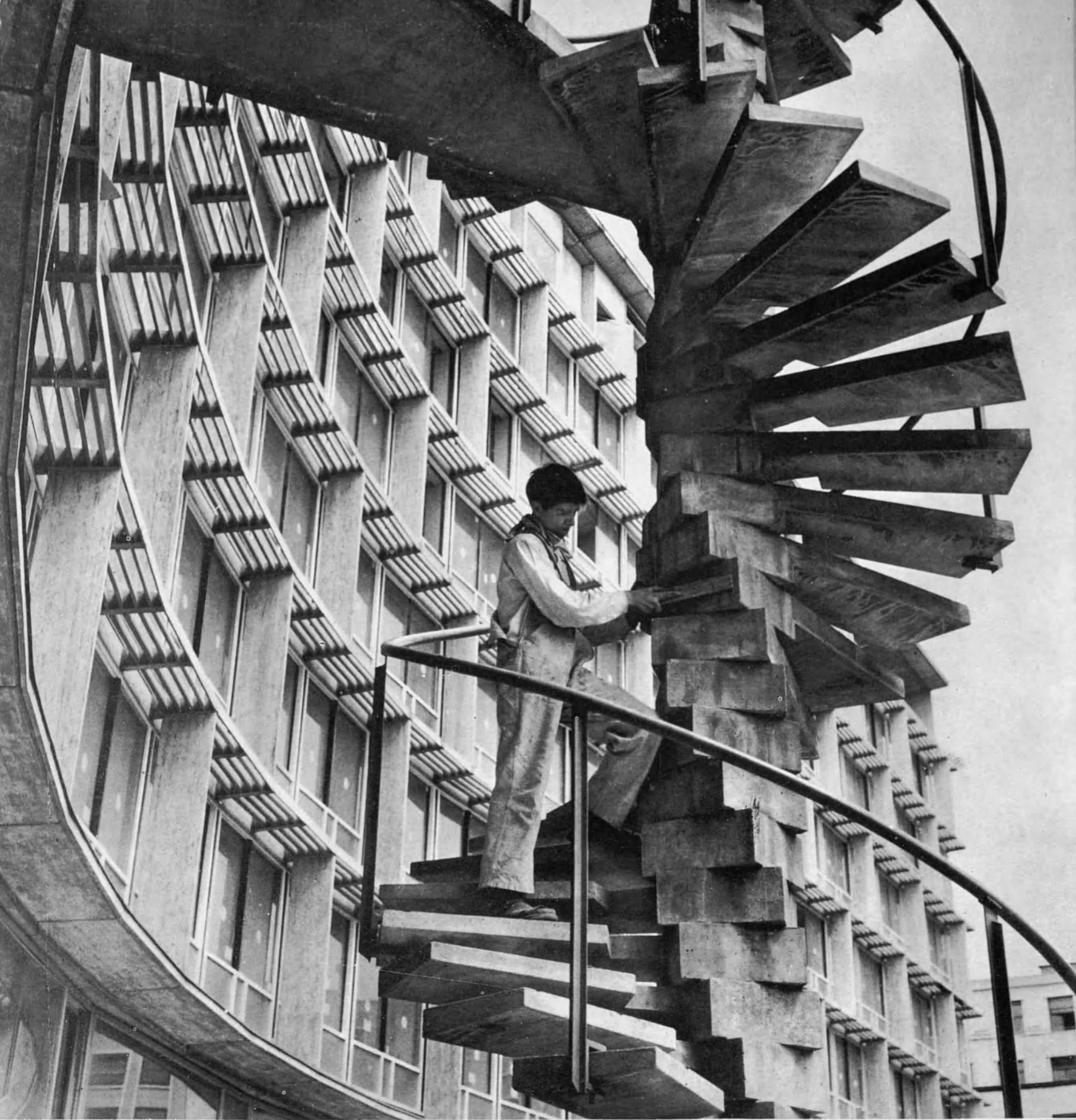
LA ESCALERA EN ESPIRAL de cemento armoniza con la fachada moderna de una de las alas del Edificio de la Secretaría, cuya forma es de una Y horizontal. Esta escalera —destinada a los bomberos en caso de incendio— está construída alrededor de un eje formado por un conducto de agua y posee en cada descanso de piso un conmutador para manguera de incendio.
