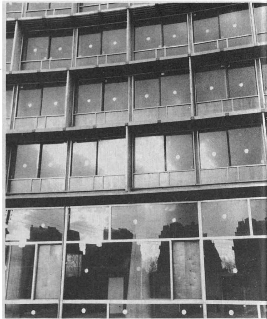
UNA CASA DE VIDRIO. Entre el 14 de abril de 1955, fecha de la primera paletada, y los últimos días de julio de 1958, en que se terminó lo más fundamental de la obra, el "cuartel de Fontenoy" ofreció al público parisiense el espectáculo de una cantera gigantesca en donde
