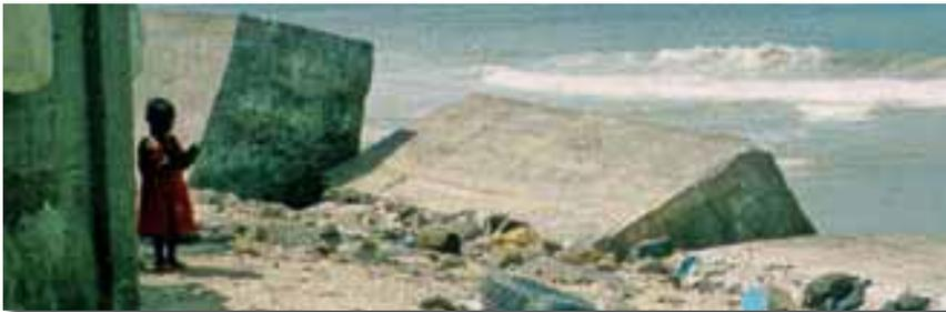
Socavado por el oleaje, el muro de Rufisque se derrumbó.
