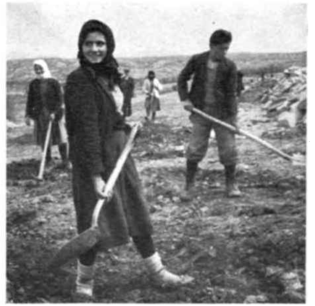
Construcción de nuevas carreteras en Grecia.
