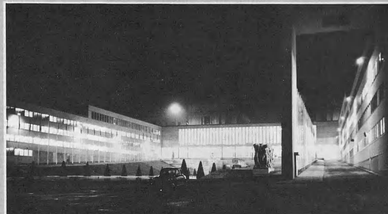
UN PALACIO PREFABRICADO albergó temporalmente a la Asamblea General de las Naciones Unidas en 1948 y 1951. Los edificios "temporales" fueron erigidos especialmente en los jardines del Palacio de Chaillot en París, y están todavía en servicio.
