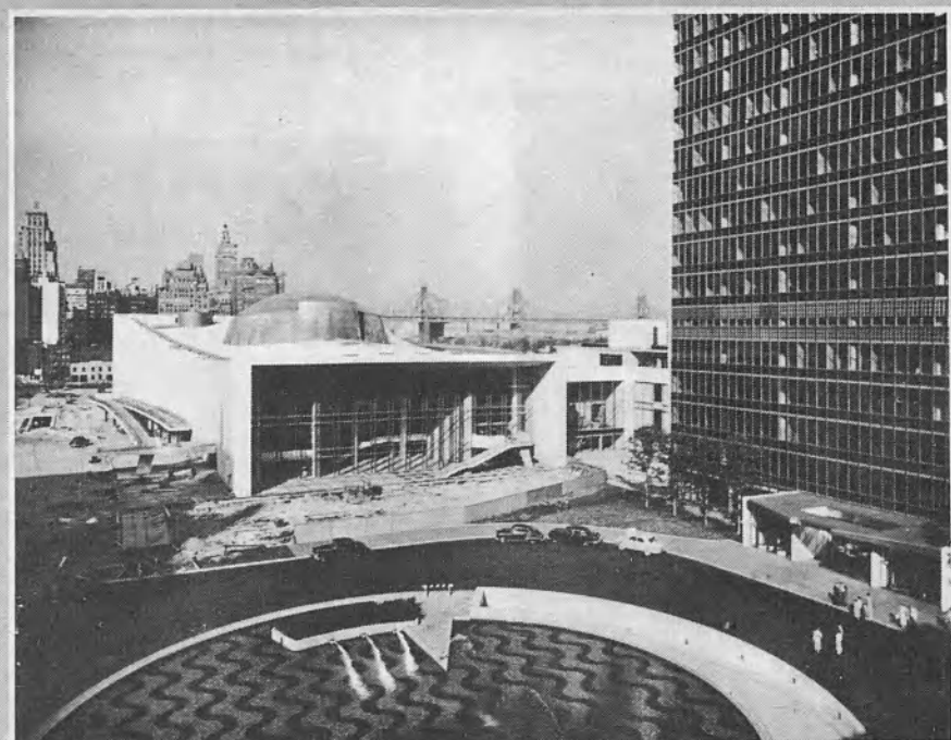
LA SEDE PERMANENTE de la ONU está construida en el corazón de Nueva York. El edificio de la Secretaría (derecha) tiene 39 pisos. La Asamblea General en el centro.
