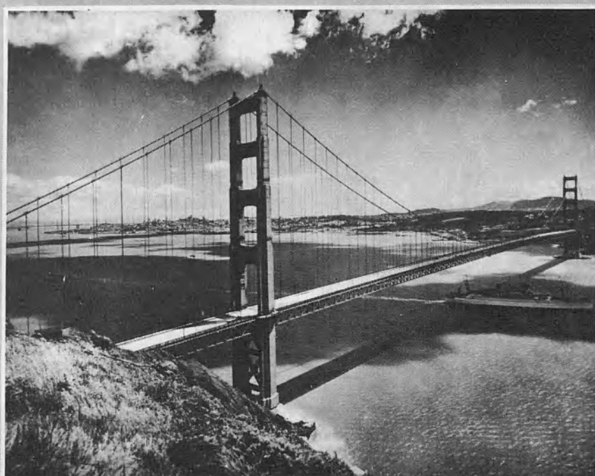
LA CIUDAD DE SAN FRANCISCO , cuna de las Naciones Unidas, se divisa más allá del "Golden Gate" (Puerta de oro) el más extenso puente suspendido del mundo.
