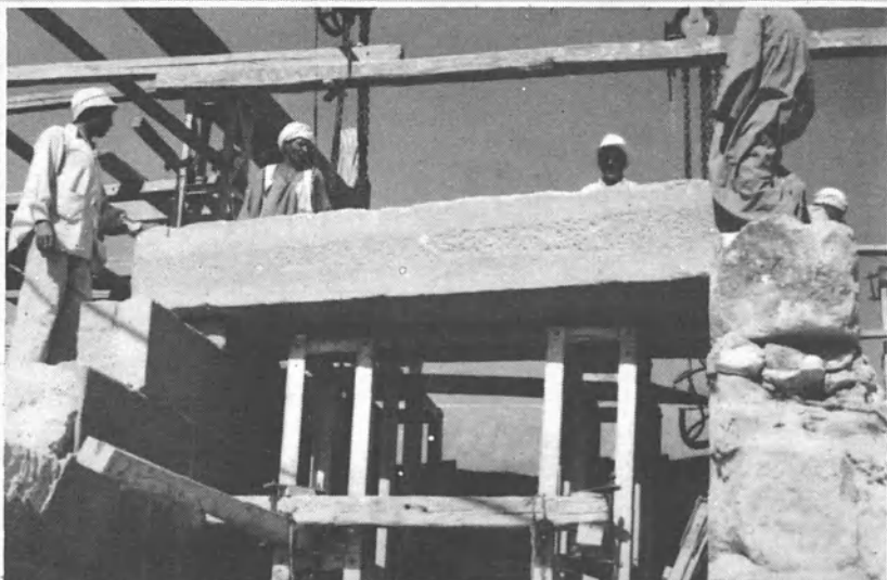
A lo largo de las orillas del Nilo una serie de templos están siendo metidos en cajones. Arriba se ve un trozo del templo de Kertasi numerado y empaquetado para su transporte fluvial.
