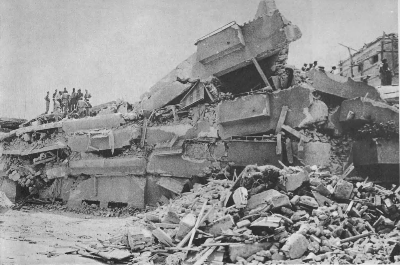
UN MONTON DE ESCOMBROS es todo lo que queda de un edificio de varios pisos, destruidos los suelos y apilados en capas que lo asemejan a una concertina por el terremoto de Skoplje. Es susceptible de reparación menos de la tercera parte de los 35.000 edificios de la ciudad yugoeslava. Esta, que contaba 220.000 habitantes y tenía una extensión de 70 kilómetros cuadrados, se había visto ya seriamente perjudicada por otros dos terremotos en el año 518 y en el 1904.
