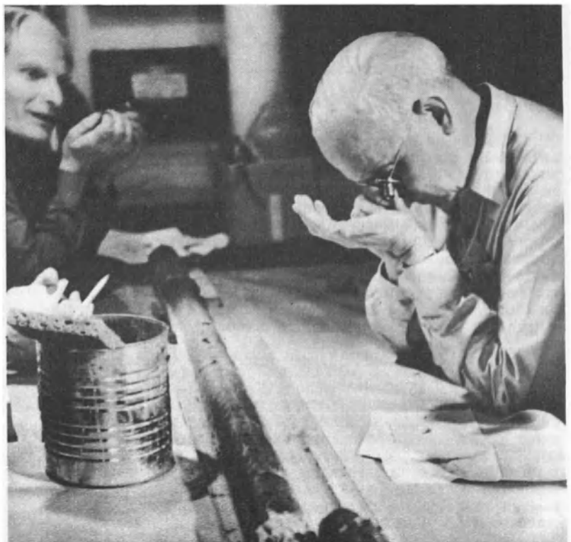
Arriba, los técnicos inspeccionan en el barco que hizo la perforación de prueba el tubo protector de la cañería de perforación, tubo que limita la combadura de que pueda ser objeto esa cañería cerca de la superficie. En el curso de la perforación el piloto del barco tuvo que mantenerlo en el centro de un anillo de boyas. Si las olas lo hubieran empujado fuera de ese círculo, el perforador se habría roto violentamente. Abajo, los científicos examinan los primeros cilindros de roca extraídos a trescientos metros bajo el lecho oceánico.
