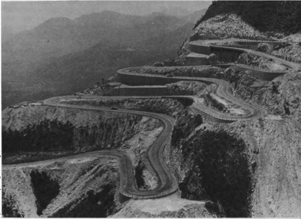
Esta carretera, construida en las faldas escarpadas de los montes Chala (Angola), une el puerto de Mossamedes con el interior del país.
