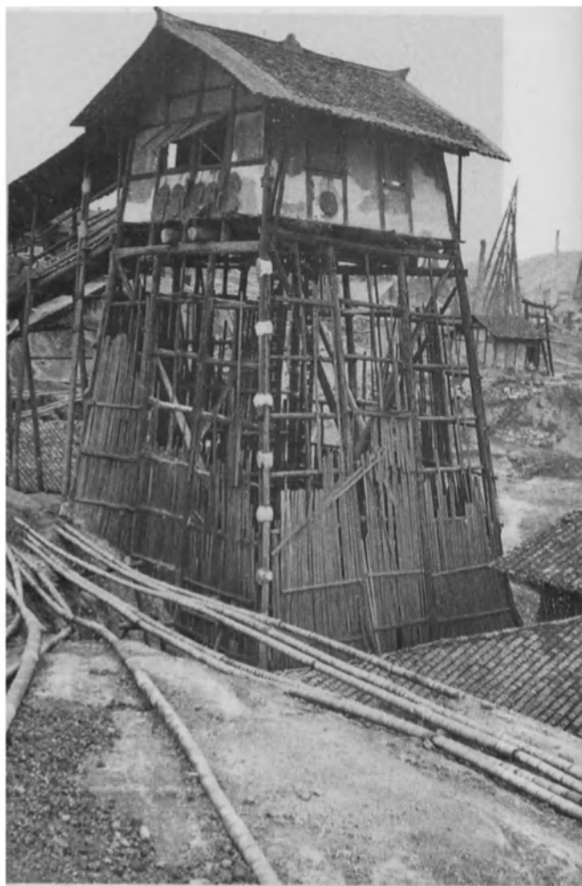
Estructura de un pozo petrolífero con otras torres al fondo, en la provincia de Sichuán. En primer término aparecen las tradicionales tuberías de bambú para conducir el gas natural hasta las ciudades.
