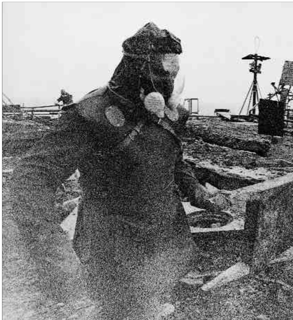
Después de la explosión del reactor, 50.000 "liquidadores" limpiaron por turnos su techo
