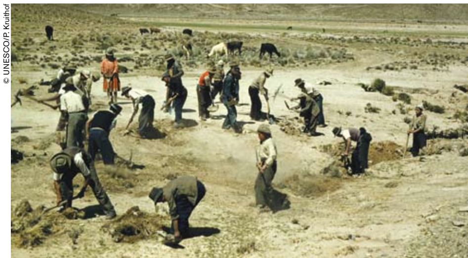
Construcción de una carretera en el altiplano boliviano.
